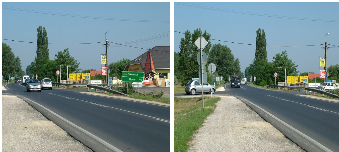
1.- 2. fotó A 4. sz. főút monori szakasza
