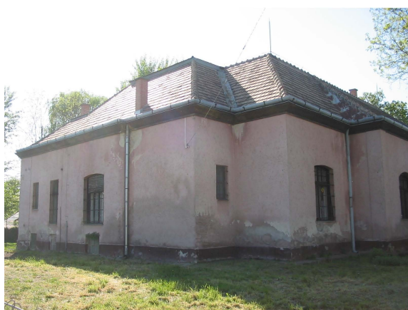
14.fotó A bölcsőde épülete jelenleg
